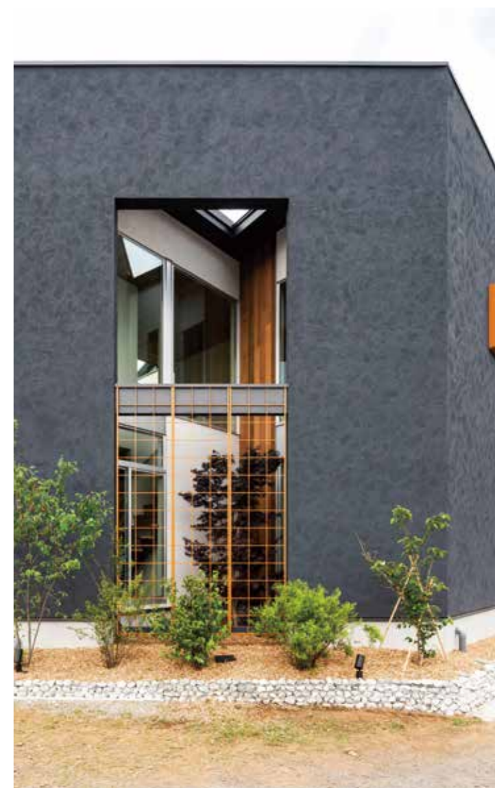
施工：共栄建築有限会社 外壁：ユニプラルHY+ #417 浮雲
